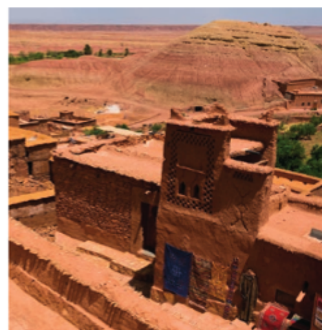
▲ Tradycyjnie podstawowym materiałem do budowy domów na pustyniach gorących, np. w Maroku, jest glina.
